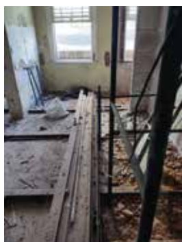
Retirada do piso existente
