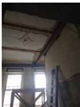
Reforços estruturais laje do 3º pavimento
