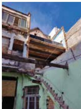
Vista de como está a demolição por trás do prédio
