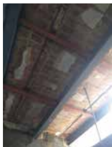
Reforços estruturais laje do 3º pavimento
