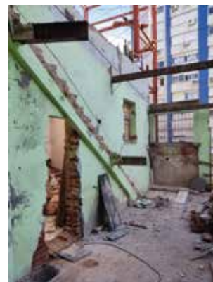
Demolição da escada externa
