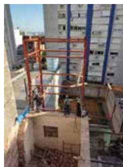
Início da retirada da estrutura de aço
