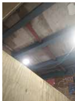
Reforços estruturais laje do 2º pavimento
