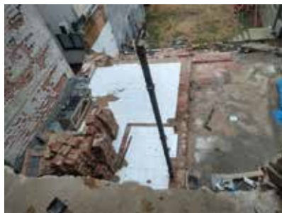
Vista da área demolida
