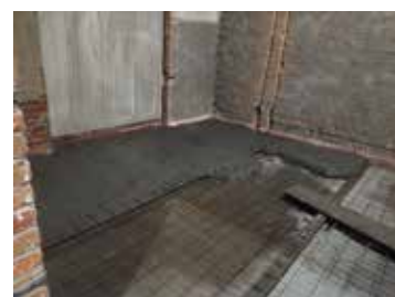
Execução do enchimento de piso com concreto leve no 2º pavimento
