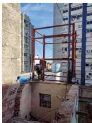
Demolição da estrutura
