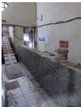
Reboco na parede que está sendo realizado no subsolo
