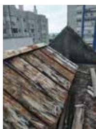
Verificação dos vitrões da cobertura
