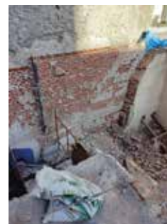
Demolição no segundo pavimento
