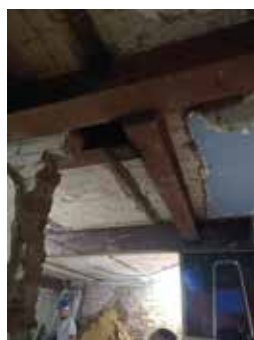
Reforços estruturais laje do 2º pavimento
