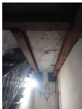
Reforço estrutural para demolição da escada
