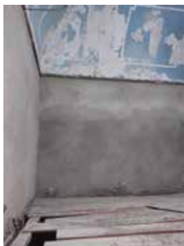
Realizado reboco da parede das escadas que vão ao terceiro pavimento
