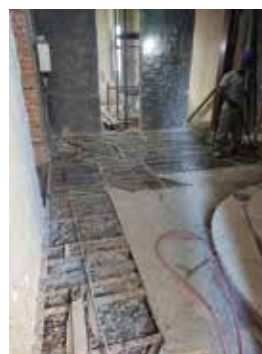
Retirada do piso de madeira
