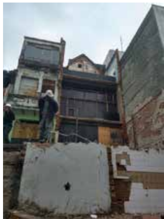
Vista dos fundos da casa com a parte demolida
